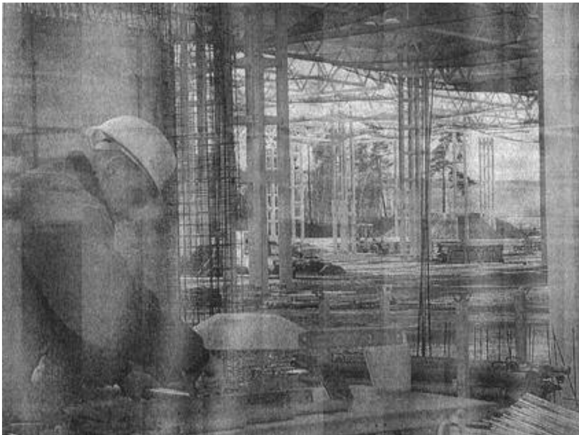
Blick in die künftige Werkshalle von Mercedes in Ludwigsfelde: Maik Baranski sägt Abstandshalter für die Schalungen zu. Gestern haben die Mitarbeiter der Brandenburger Firma HIB die Betonwände für einen dreistöckigen Anbau gefertigt.
