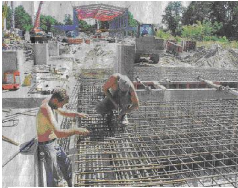
Unter sengender Sonne: Mitarbeiter der Firma Hoch- und Ingenieurbaugesellschaft bereiten das Betonieren eines Fundamentes vor. Der Boden besteht aus Unterwasserbeton. FOTO: RENEE ROHR
